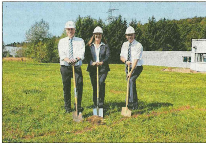
Am vergangenen Freitag fand in Wilnsdorf der symbolische Spatenstich der Firma Krückemeyer mit Wilnsdorfs Bürgermeisterin Christa Schuppler (Mitte) „Auf'm Lehnscheid“ statt. Foto: Fa. Krückemeyer
